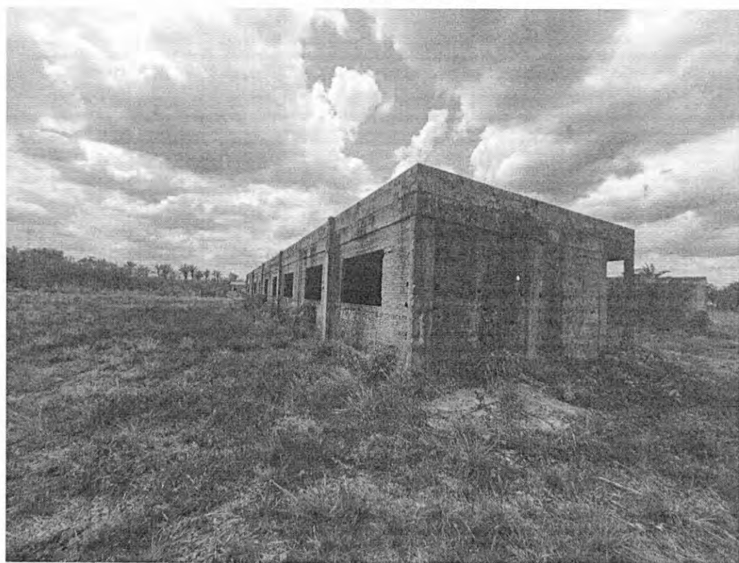
Figura 30 – Bloco pedagógico – Vedações com buracos, podem perder a resistência
