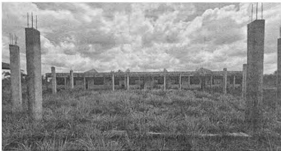
Figura 40 – Pátio coberto – Pilares executados parcialmente
