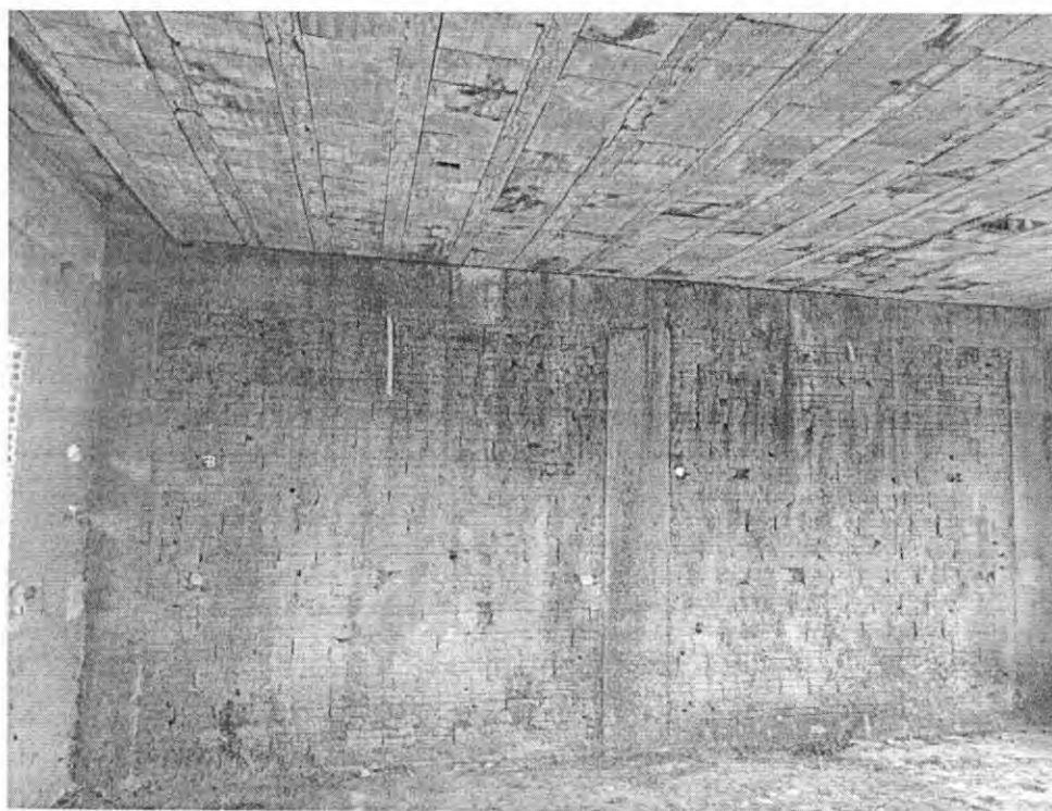
Figura 24 – Bloco pedagógico – Vigotas apresentam fissuras
