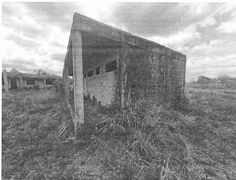
Figura 10 – Bloco administrativo – Presença de limo e mofo na alvenaria Fonte: elaboração própria
