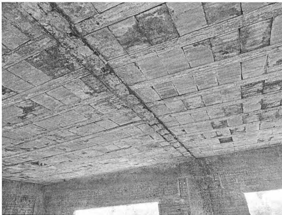
Figura 23 – Bloco pedagógico – Laje apresenta ferragens oxidadas
