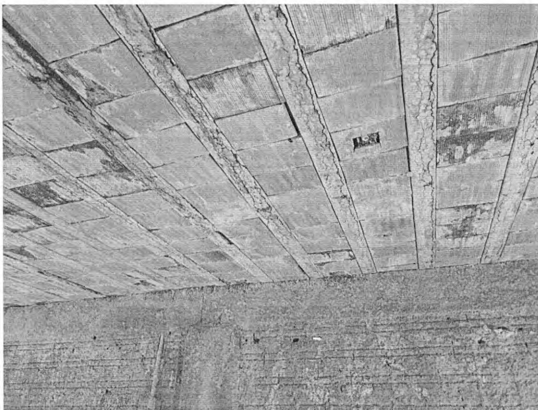
Figura 25 – Bloco pedagógico – Vigotas com corrosão
