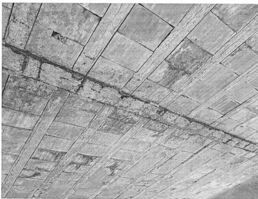
Figura 22 – Bloco pedagógico – Laje apresenta ferragens oxidadas
